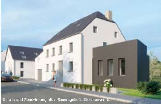
Umbau und Renovierung altes Bauerngehöft, Niederanven (L)
