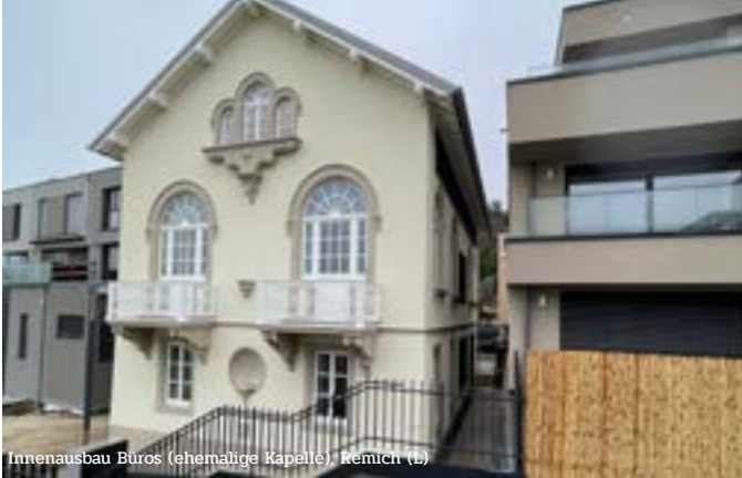
Innenausbau Büros (ehemalige Kapelle), Remich (L)
