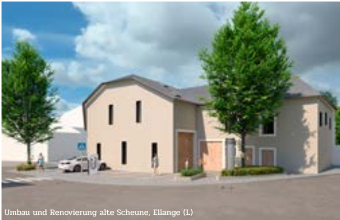
Umbau und Renovierung alte Scheune, Ellange (L)
