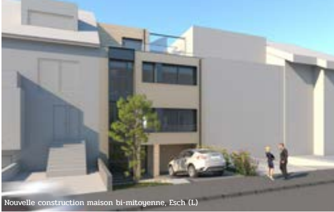
Nouvelle construction maison bi-mitoyenne, Esch (L)
