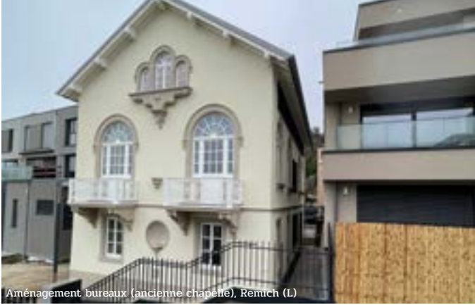
Aménagement bureaux (ancienne chapelle), Remich (L)
