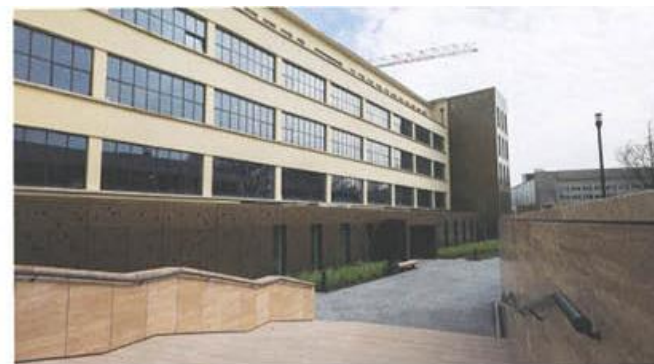
Côté cour, le pied de l'immeuble a été retravaillé et une nouvelle extension construite.
